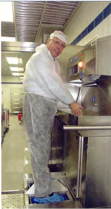
Im Check: Planer Hans-Georg Kolb testet die Schmutzschleuse zwischen unsauberem und sauberem Bereich der Spülküche.
